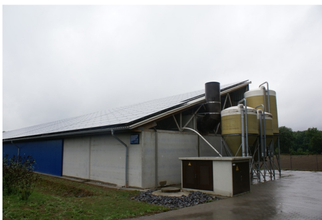
Stal waarvan het gehele dak met zonnepanelen is bedekt (foto Rienk Ter Braake)
